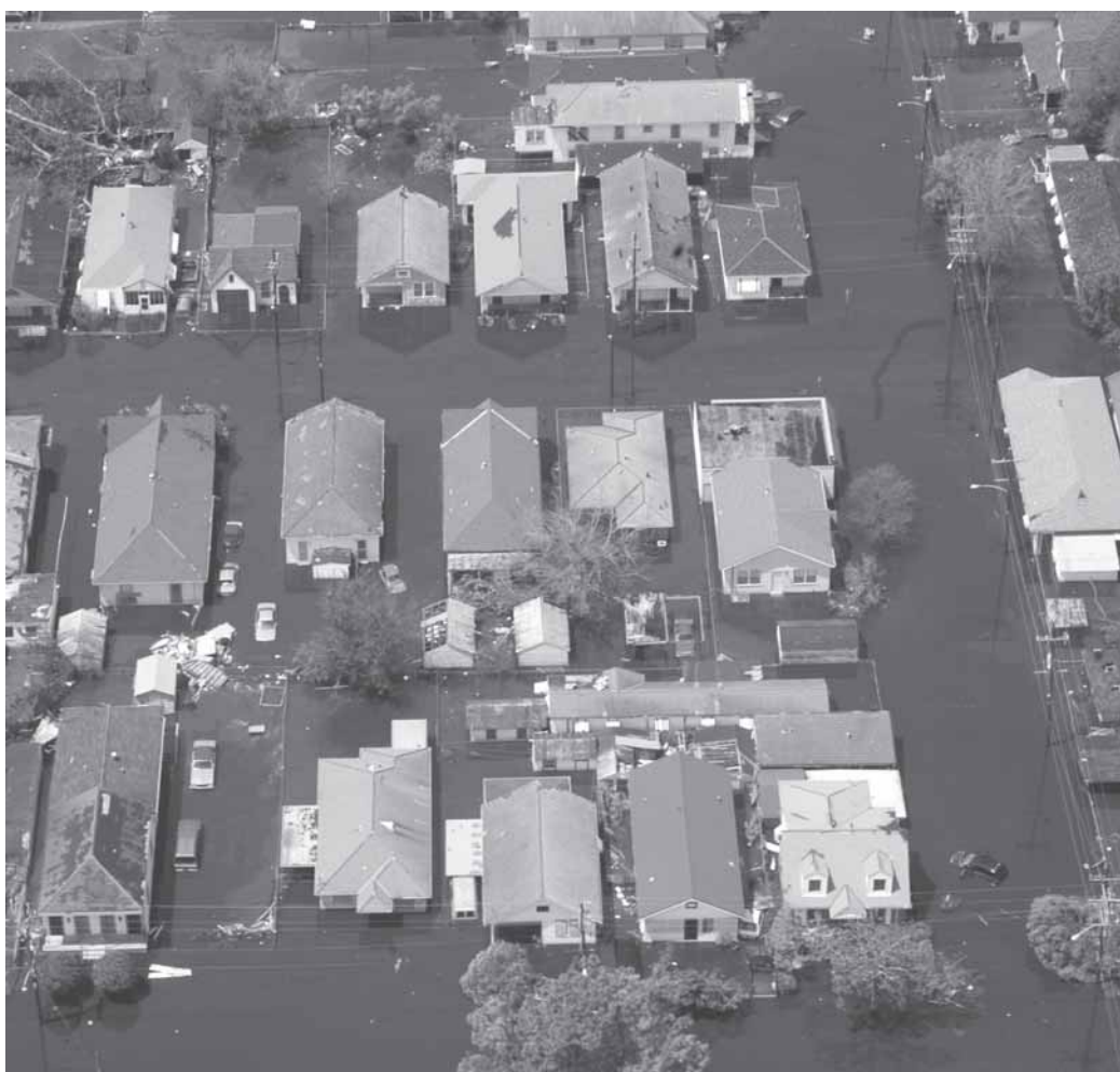
La vista del aire de la inundación que continua de los efectos del huracán Katrina.
